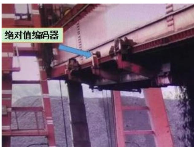
图 2.21 移动皮带小车绝对值编码器安装位置示意图
