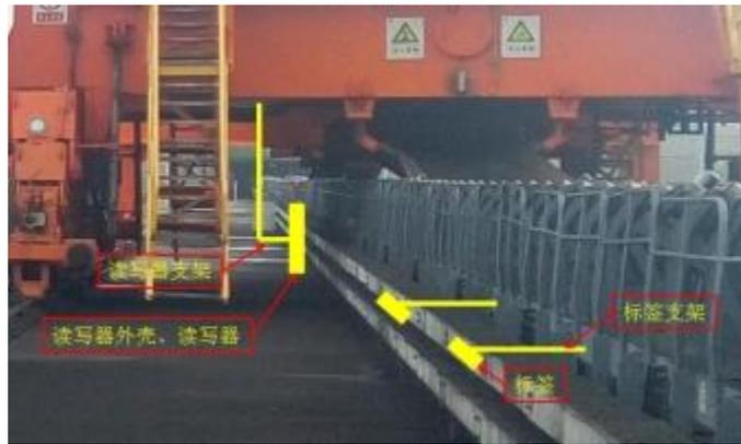
图 2.24 射频定位系统安装
